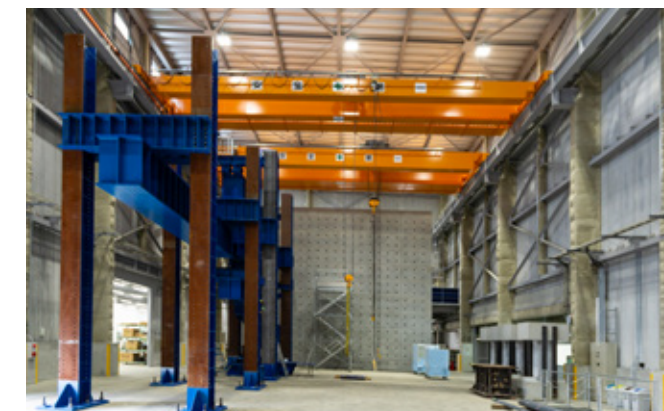
多目的実験棟の構造実験エリア
