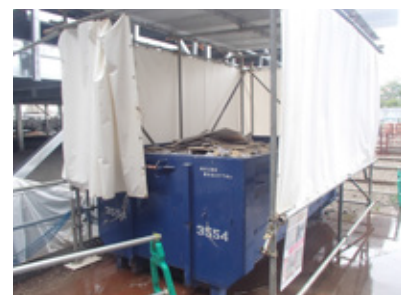
石膏ボード分別ヤード(屋根とシートによる防雨対策)
