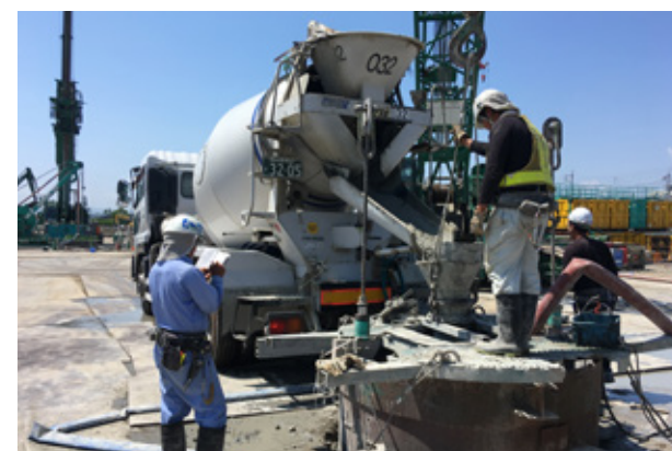
杭コンクリート打設
