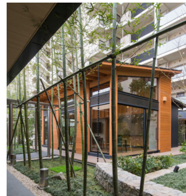
中庭の共用棟
