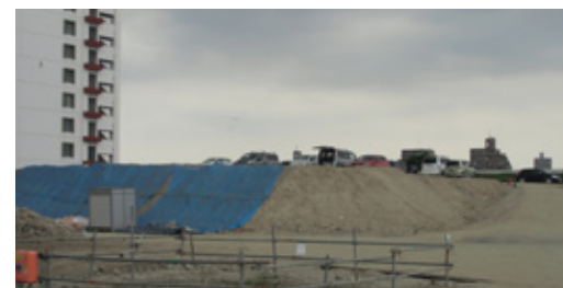
掘削残土の場内堆積状況
