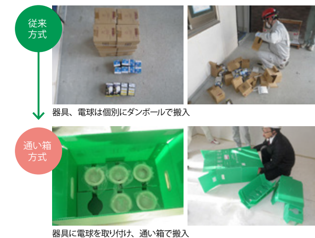
従来方式: 器具、電球は個別にダンボールで搬入 通い箱方式: 器具に電球を取り付け、通い箱で搬入
