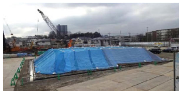
飛散防止対策の状況
