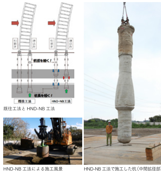
HND-NB工法による施工風景 HND-NB工法で施工した杭（中間拡径部）
